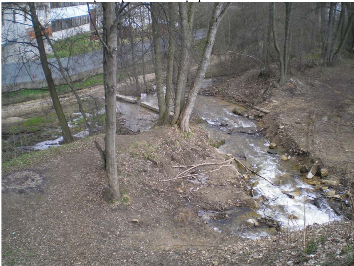
Horní tok Slavonického potoka pod železničním propustkem
