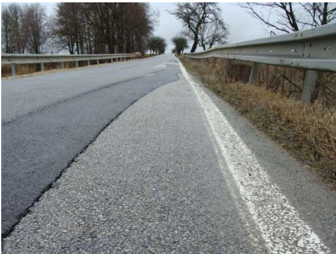
Deformace koruny hráze rybníka Velký slavonický
