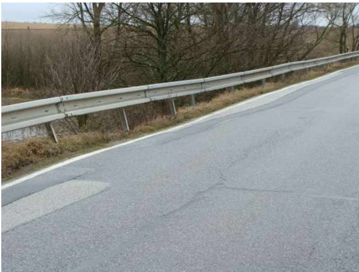
Deformace koruny hráze rybníka Velký slavonický
